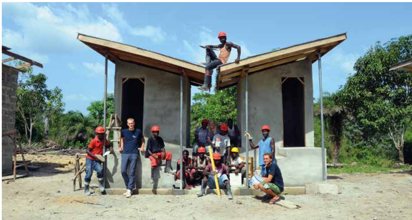
Einheimische Arbeiter und das Team von Ing. ohne Grenzen bei den Arbeiten vor Ort.
